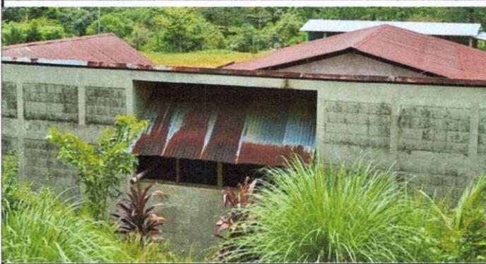
Foto 1: La cubierta de lámina se encuentra en mal estado. En época de lluvia el agua se infiltra. Deteriorando el edificio.
