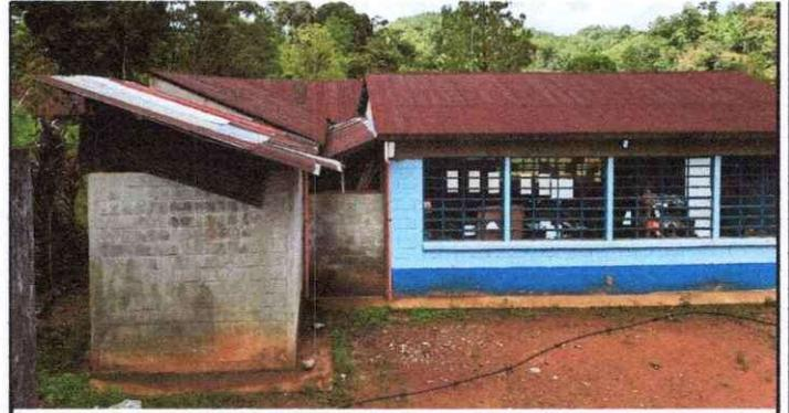
Foto 4: Cocina demasiado pequeña, láminas y estructura en mal estado.
