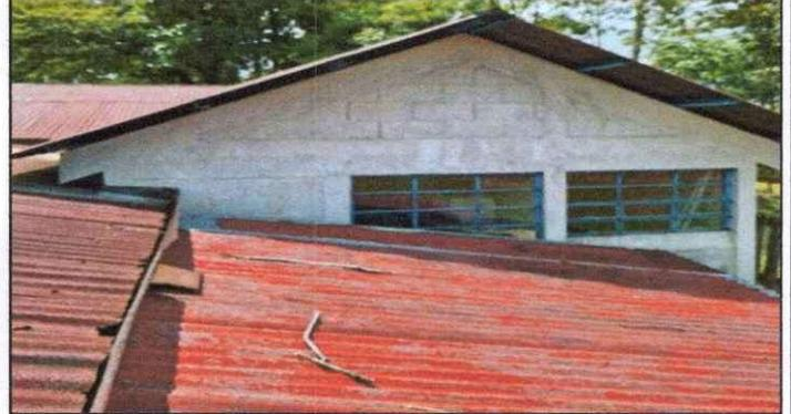
Foto 2: Vista de la parte frontal, láminas oxidadas.
