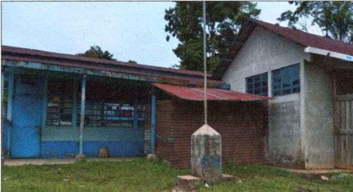
Foto 3: Parte frontal del edificio a cambiar de techo, canales y láminas; oxidados.
